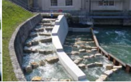
Die Fischtreppe wurde 2008 komplett modernisiert.
