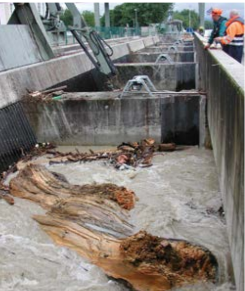
Der Rhein schwemmt besonders bei Hochwasser große Äste oder auch ganze Bäume an.
