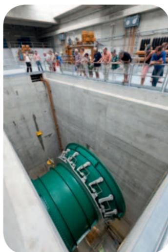
*Blick in den Maschinensaal des Kraftwerks. Durch eine Turbine fließen bis zu 375 000 Liter Wasser pro Sekunde. Durch die verstellbaren Schaufeln des Leitapparats (im Bild grün) wird der Wasserzufluss zum Lauftrad reguliert. Vier Rohr-Turbinen produzieren jährlich 600 Mio. kWh Strom. Damit können rund 170 000 Haushalte mit Strom aus erneuerbarer Wasserkraft versorgt werden.*
