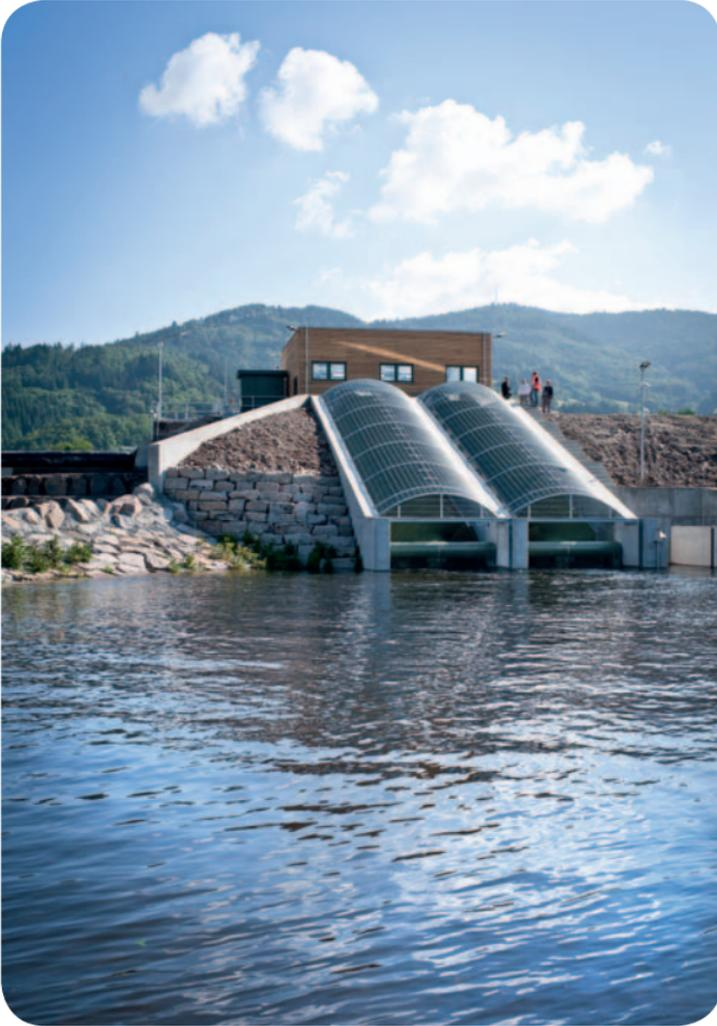
*Die doppelte Wasserkraftschnecke des Kraftwerks in Hausen produziert jährlich 1,9 Mio. kWh Strom aus erneuerbarer Wasserkraft. Damit können rund 600 Haushalte mit klimafreundlichem Strom versorgt werden.*
