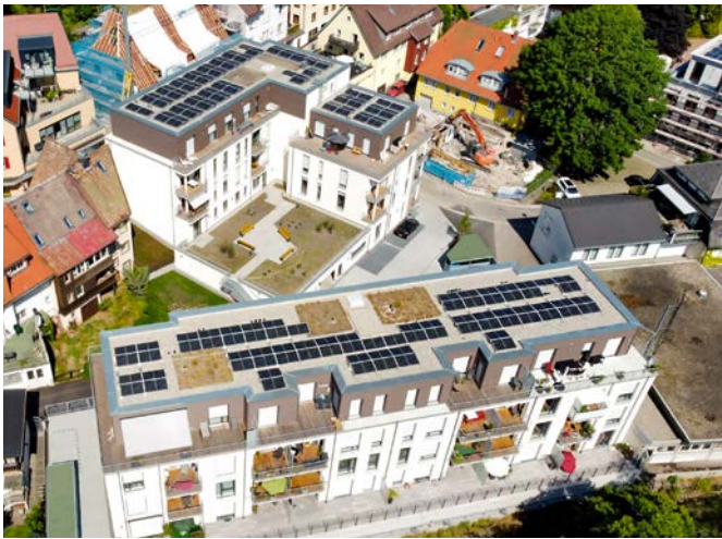
Photovoltaik, Blockheizkraftwerk und Ladeinfrastruktur für E-Autos ergänzen sich optimal in der neuen Wohnanlage in Titisee-Neustadt.
