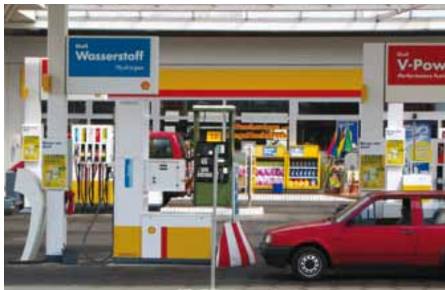
Abbildung 10: Shell-Tankstelle am Sachsendamm in Berlin, 2011
