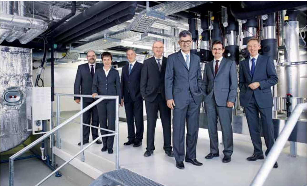
Die erweiterte Geschäftsleitung im Technikraum des Bürohauses in Rheinfelden (von links): Michel Schwery, Irene Knauber, Kees van Hoek, Claus Eckerle, Martin Steiger, Christian Bersier und Achim Geigle. Wärme- und Energielösungen bietet Energiedienst seit 2013 nicht nur seinen Kunden an, sondern geht hier auch mit gutem Beispiel voran.
