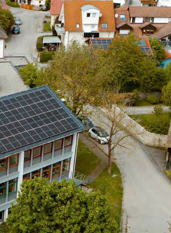
↑ Trio: In Ehrenkirchen wurden auf der Wentzingerschule PV-Module verbaut ebenso auf den Kitas St. Martin und Marienheim.
