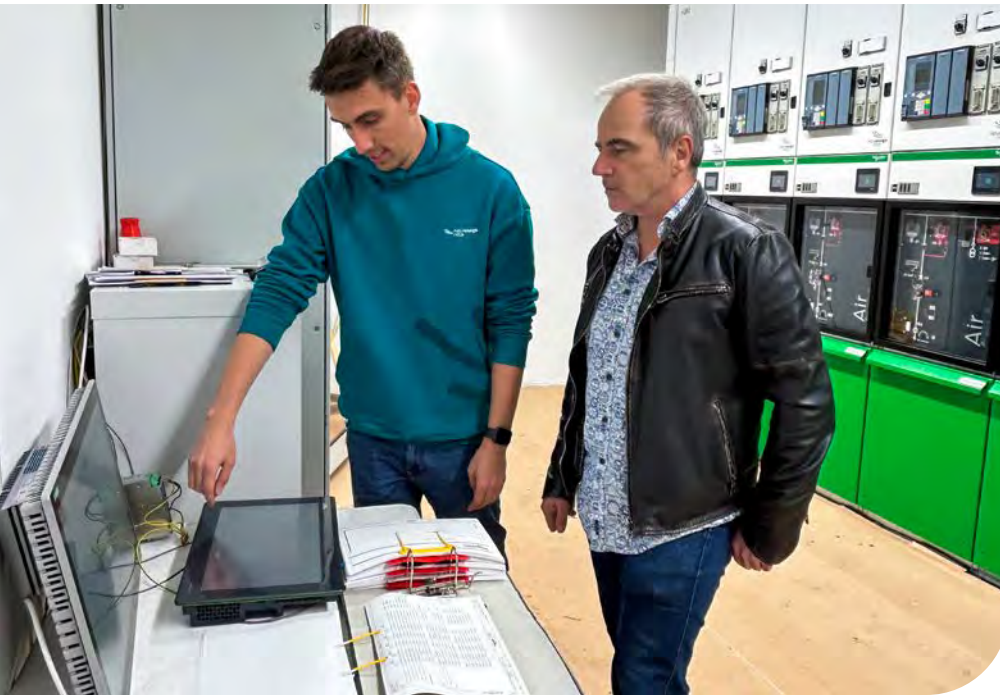
↑ Premiere: In der neuen Schaltstation in Remetschwil setzt naturenergie netze auf die aktuellste SF6-freie Schaltanlagengeneration von Schneider Electric. Pascal Meier (links) und Rainer Beck (beide naturenergie netze) testen die Technik.
